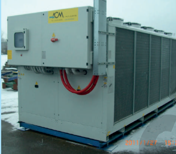
Прага мод. SCAEY 522 Производительность 480 кВт
